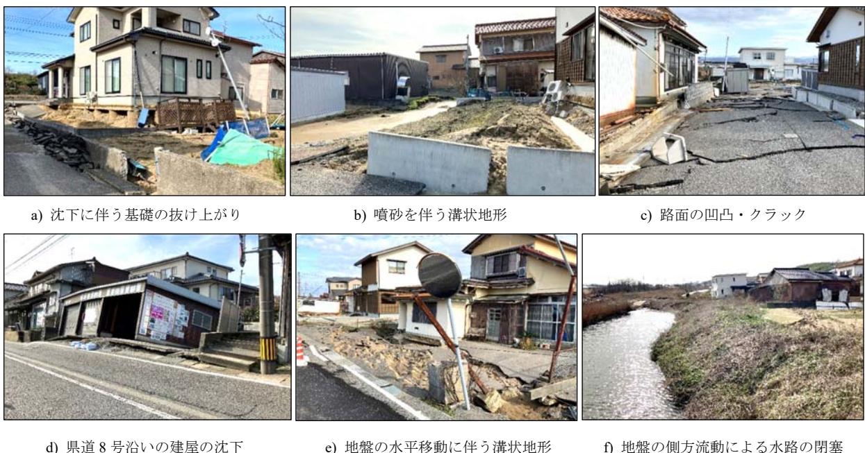
写真 1 調査地点における 2024 年 2 月 3 日時点の主な変状状況（石川県河北郡内灘町室地区）
