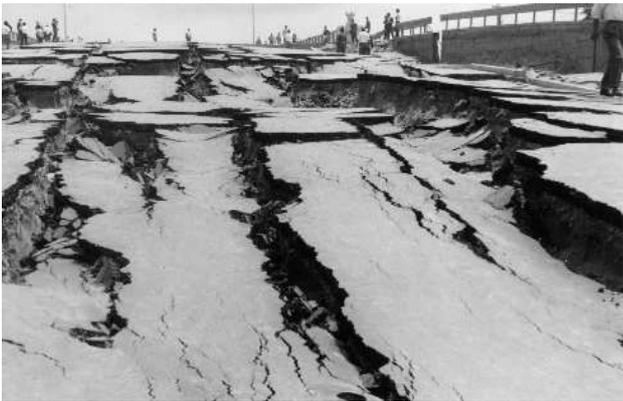
写真-3 昭和大橋の被害状況<sup>文献2)</sup>
