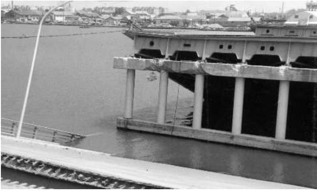
写真-2 昭和大橋の落橋被害状況<sup>文献2)</sup>
