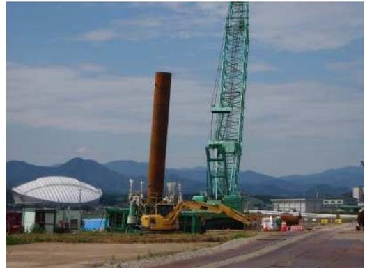
写真-1 斜杭施工状況
