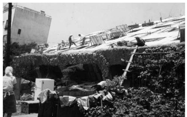
写真-1 県営アパートの液状化被害状況<sup>文献2)</sup>
